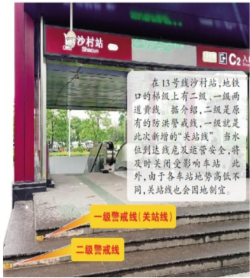
广州地铁沙村站设置 “关闭地铁站预警水位线”
