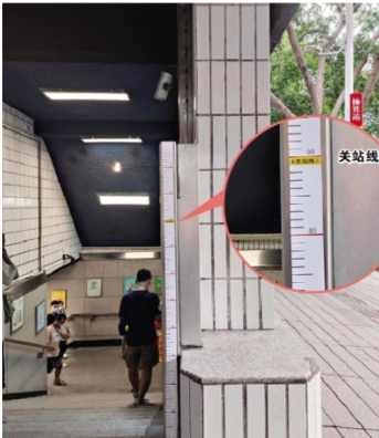
广州地铁杨箕站设置 “关闭地铁站预警水位线”
